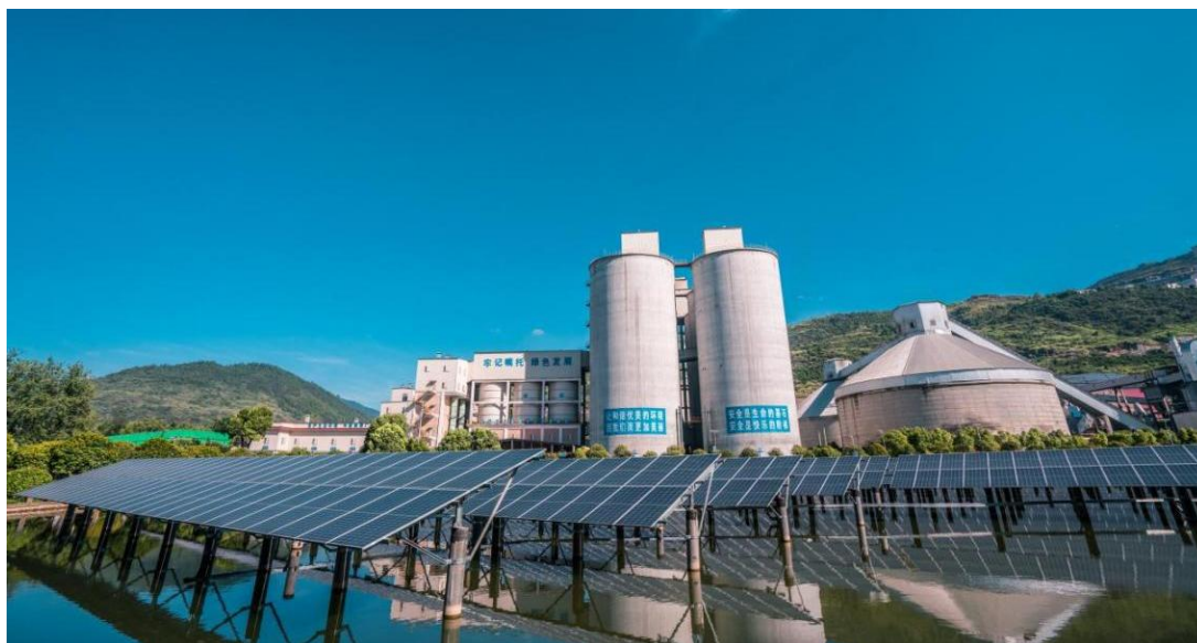
建德海螺水泥 14.7MWp 光伏+2MW/4MWh 储能一体化项目
