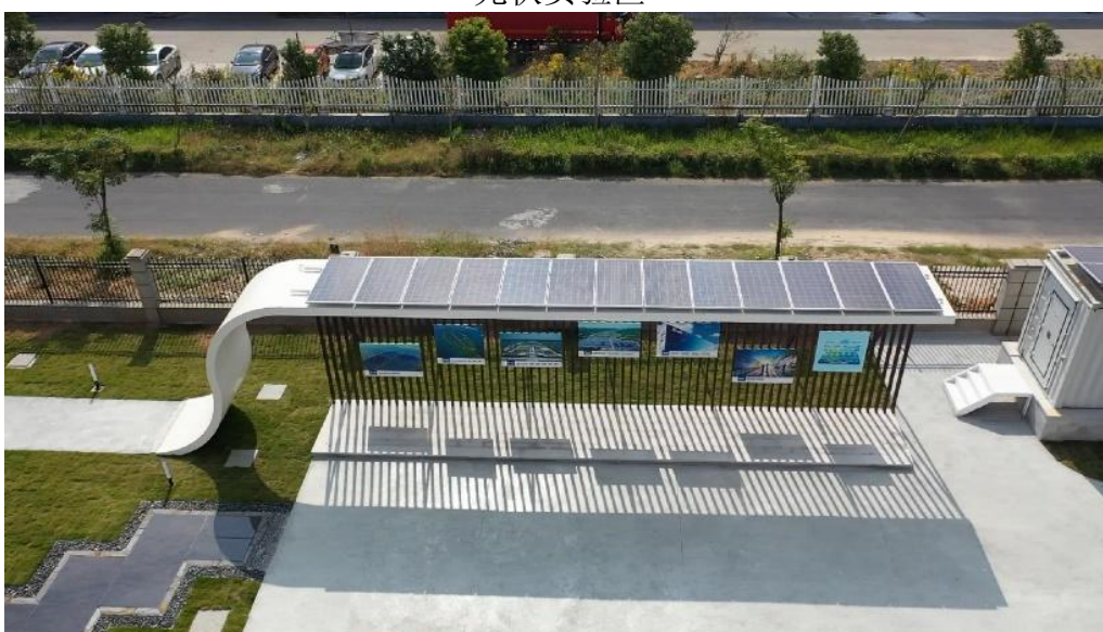
光伏飘带和光伏路
