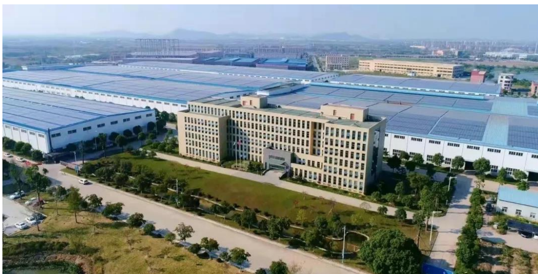
天马轴承集团有限公司厂区屋顶 30 兆瓦光伏发电项目
