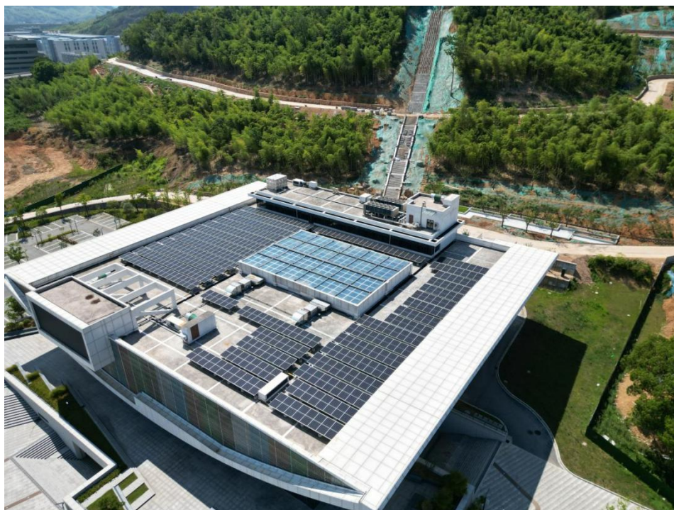
埭溪镇工业园区 15000kWp 分布式屋顶光伏项目
