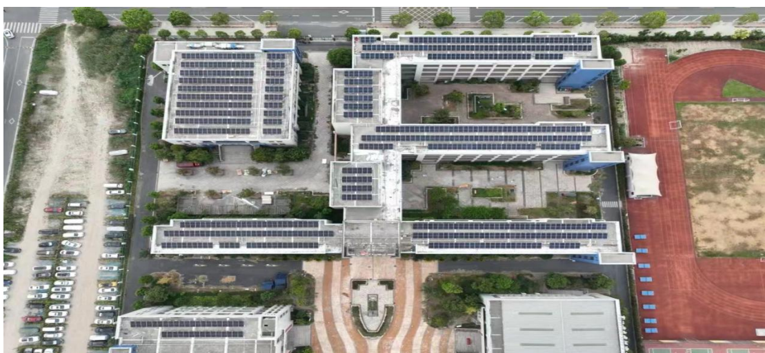
群围村学校教学办公楼屋顶光伏项目
