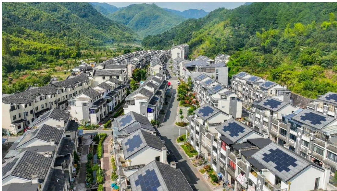
同步设计与施工后的 BIPV 光伏屋面与建筑融合
