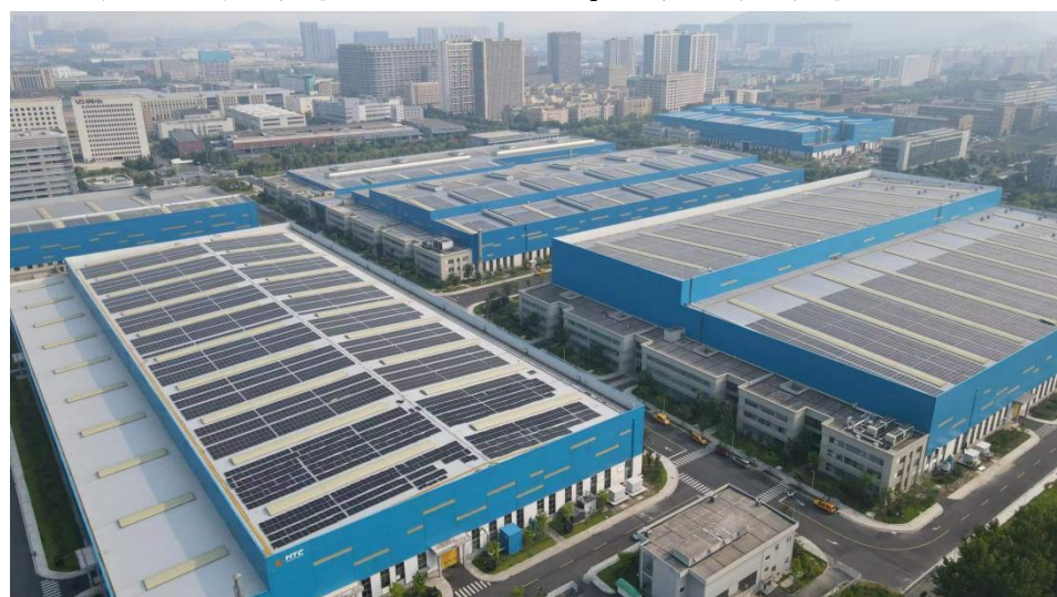
杭州汽轮重工有限公司 11945.3kWp 屋顶分布式光伏发电项目
