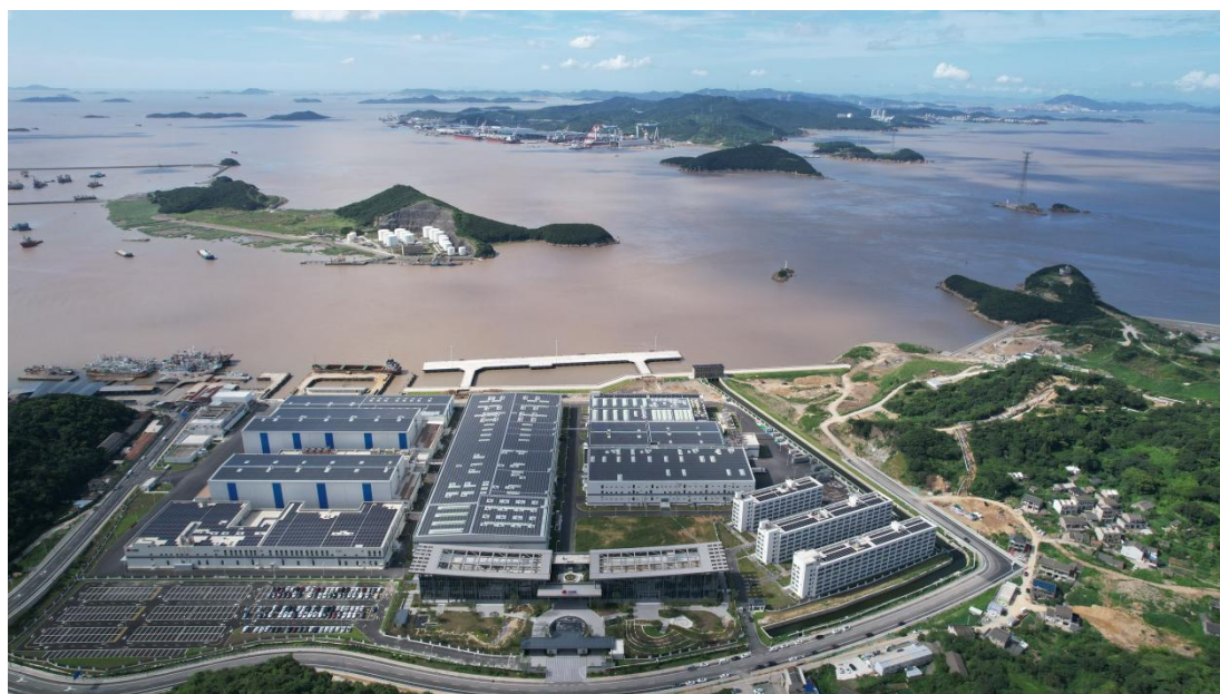
大洋世家优品园屋面 BIPV 分布式光伏发电项目
