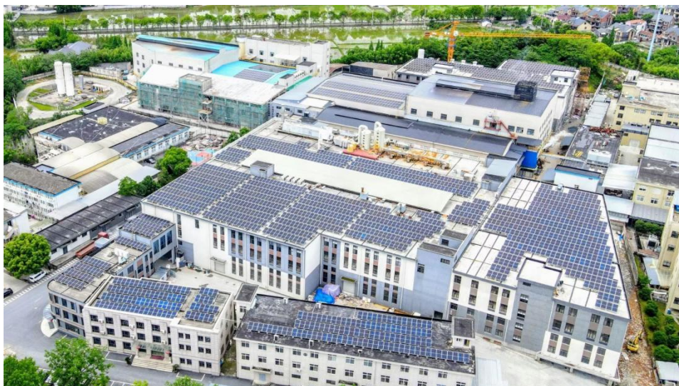
杭州三星工艺玻璃有限公司 1349.42kWp 屋顶分布式光伏发电项目
