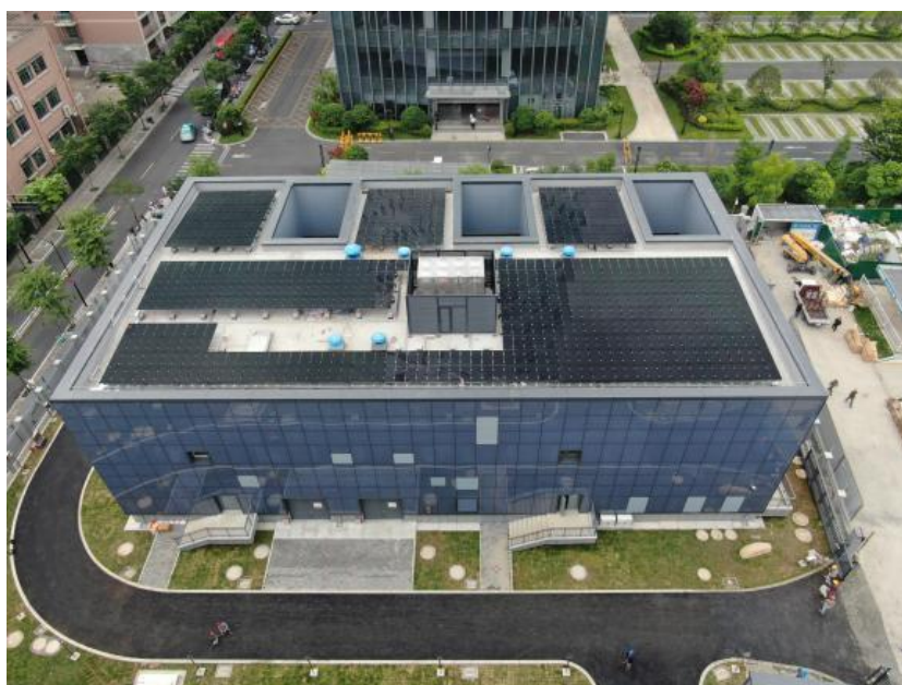
杭州小河 110 千伏变电站光伏发电项目
