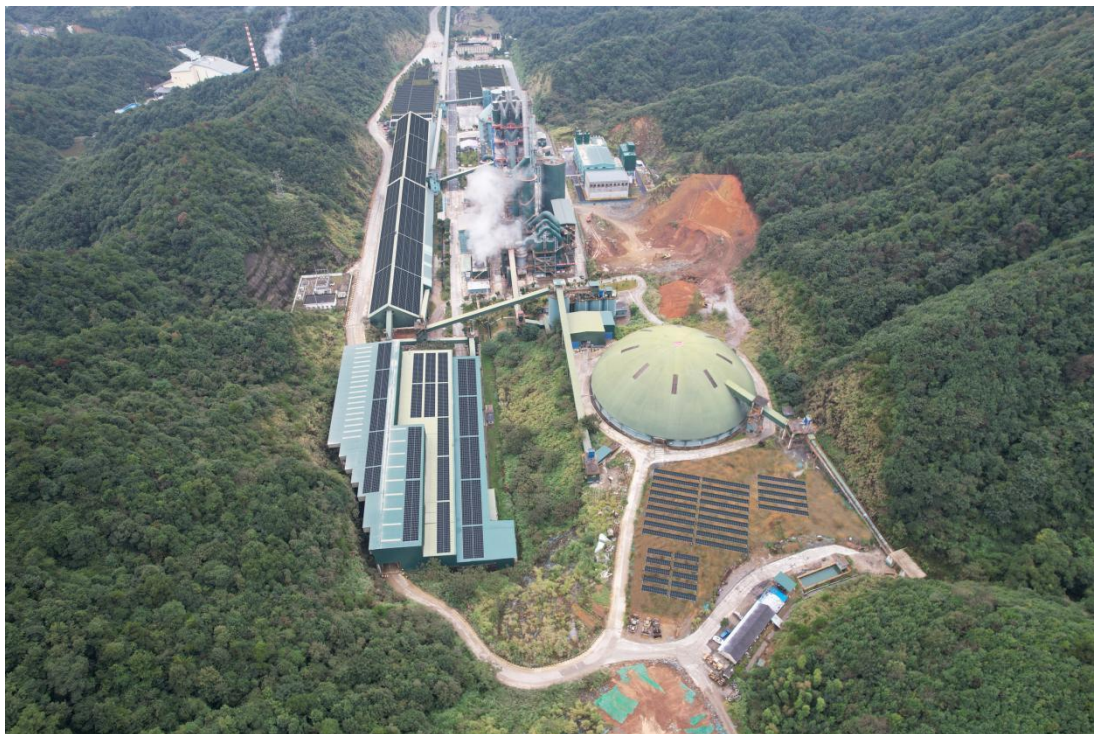
桐庐红狮新能源 6MW p 光伏 4MW/10MWh 储能一体化项目
