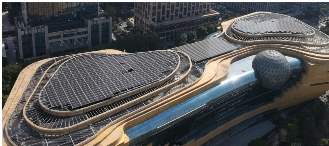
中国杭州低碳科技馆 413.6kW p 屋顶分布式光伏项目
