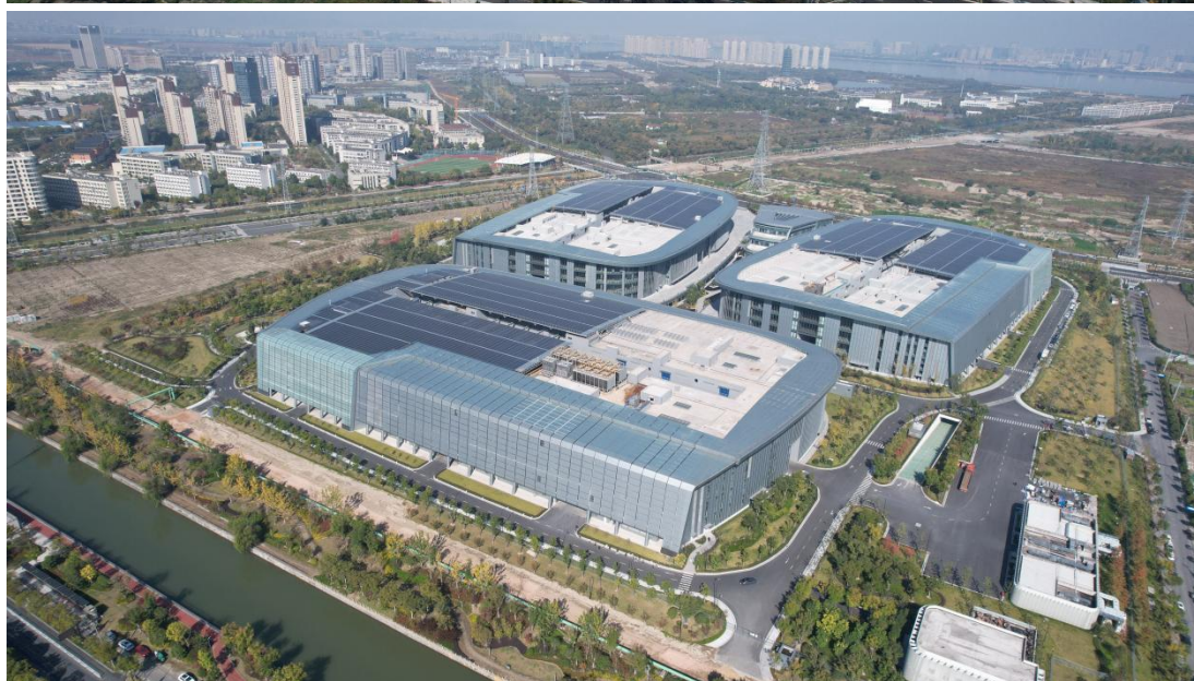
万向创新聚能城 6 号地块厂房屋面分布式光伏项目
