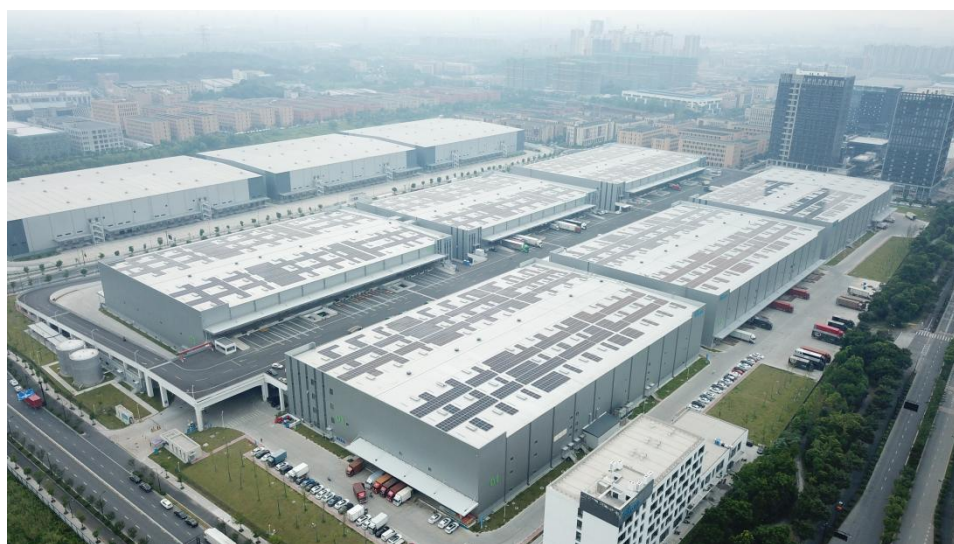
杭州仁和菜鸟光伏项目 5114.01kWp 屋顶分布式光伏发电项目
