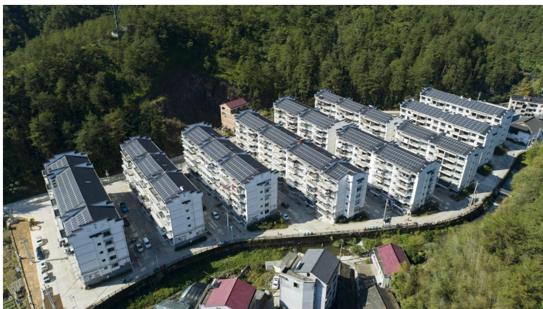
云和县浮云街道村屋顶光伏共富项目
