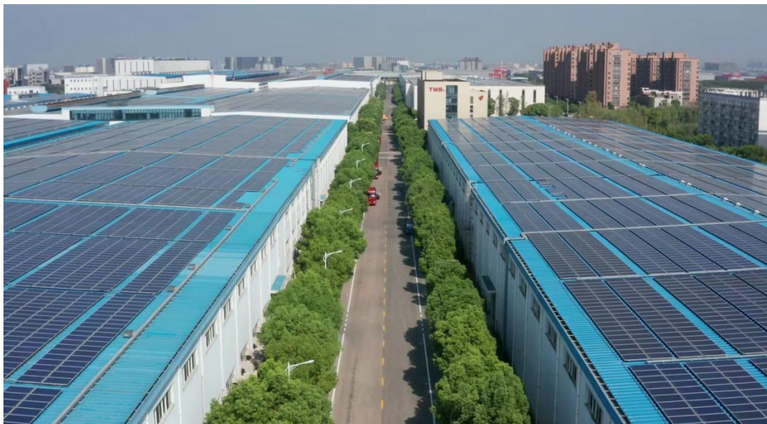
天马轴承集团有限公司厂区屋顶 30 兆瓦光伏发电项目
