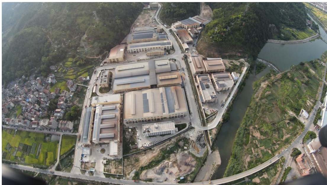
青田县东源片厂房屋顶光伏发电共富项目
