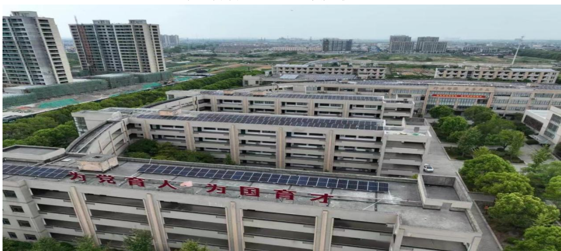
群围村学校教学办公楼屋顶光伏项目
