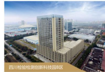
四川检验检测创新科技园B区
